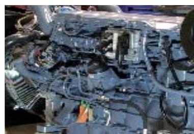
Para un buen funcionamiento del grupo, el motor debe tener la suficiente ventilación, sobretodo hay que vigilar este aspecto si es insonorizado instalado en interiores.
