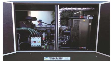
Para un buen funcionamiento del grupo, el motor debe tener la suficiente ventilación, sobre todo hay que vigilar este aspecto si es insonorizado instalado en interiores.
